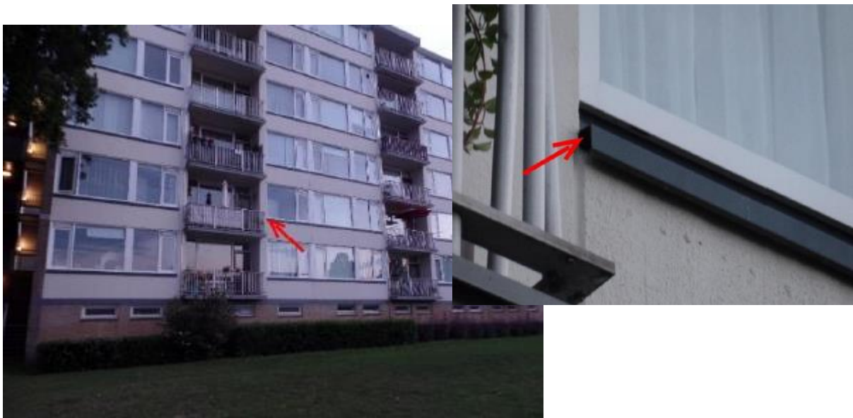
Figuur 4. Distel 1: 1 t/m 48: invliegplek aan de zijkant van de vensterbank (met 1 aangeduid in figuur 2).
