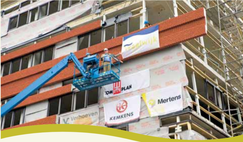
Wethouder Heuveling plaats symbolisch een gevelement
